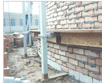
Metselen van een gebogen muur.
